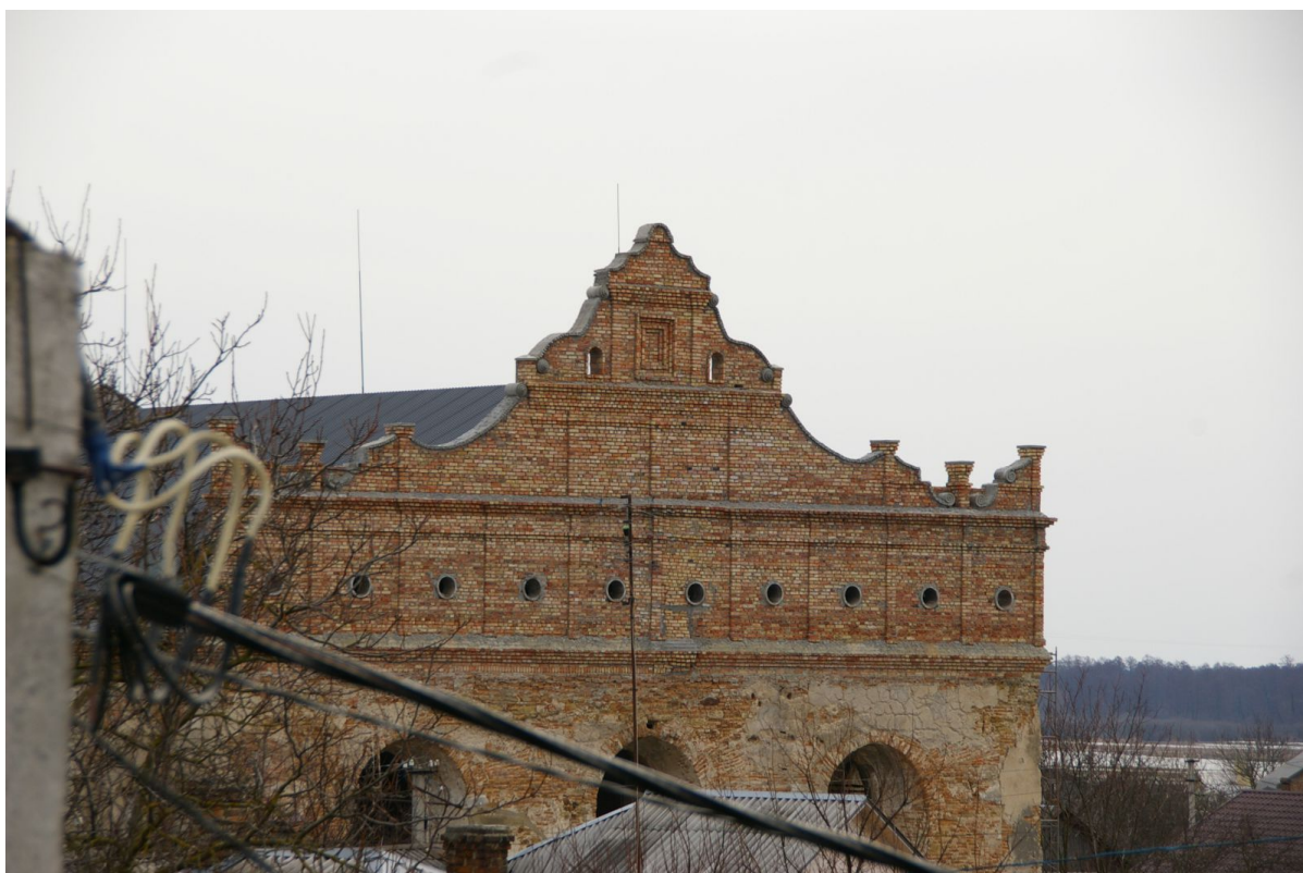
Идут строительные работы
