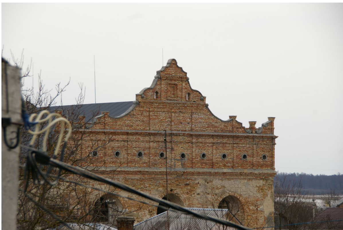
Идут строительные работы
